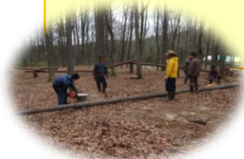
<新ドラゴンブリッジ製作>
