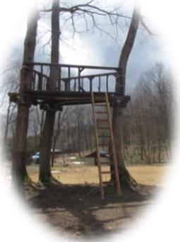
<ツリーテラス 設置完了! >
